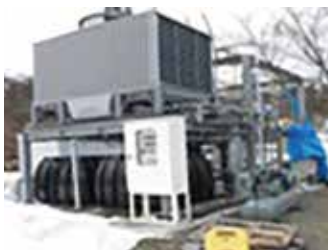
①小型バイナリー発電機設備 〈水/アンモニア混合熱媒体式 発電出力7.5㍻（最大15㍻）〉
