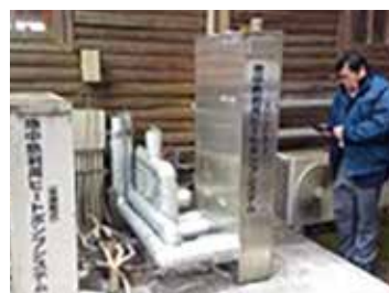
⑫石巻市中島の試験施設
